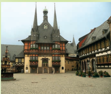
Fachwerk-Rathaus in Wernigerode, Bild: U. Kienzler
