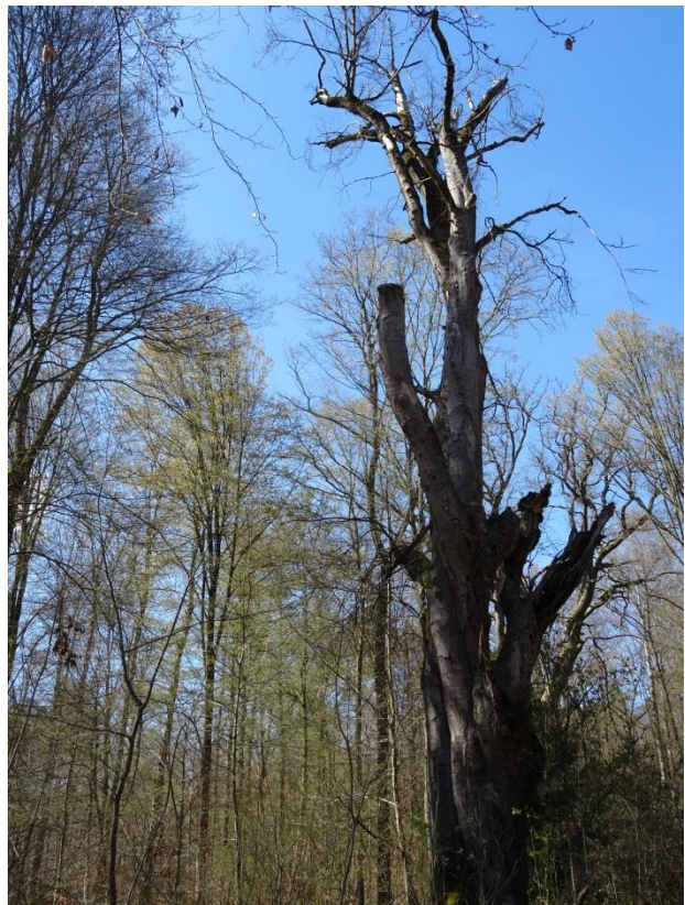
Naturschutz-Objekt intensivster Verkehrssicherung: Abgestorbene, abgespannte Buche an Erholungs-Hauptachse im Rotwildpark (Bild: Raisch).
