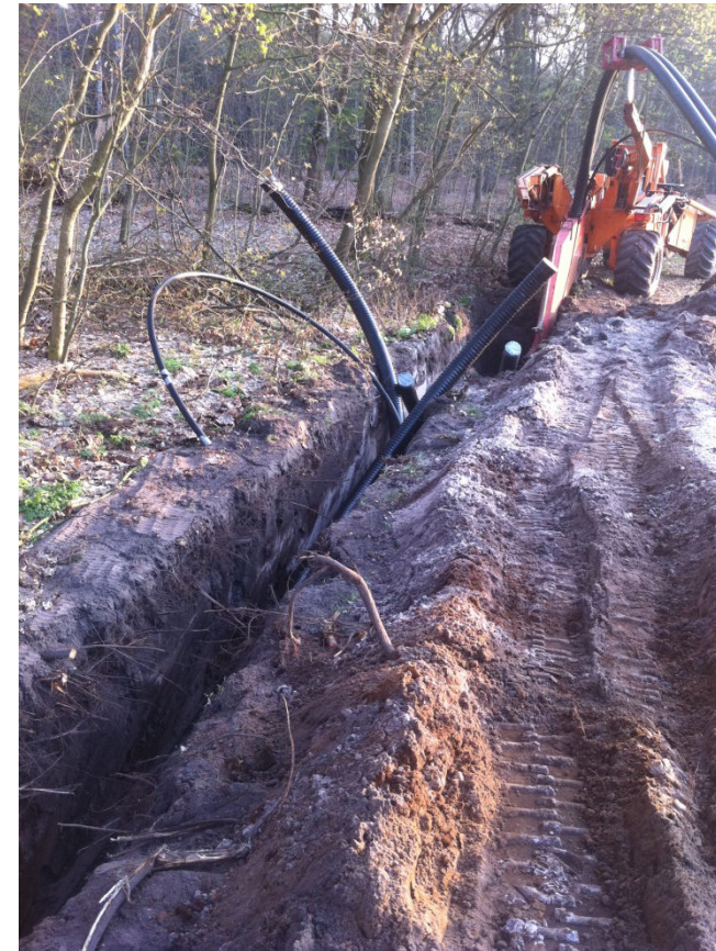
Einpflügen der Leitungen (80 cm)
