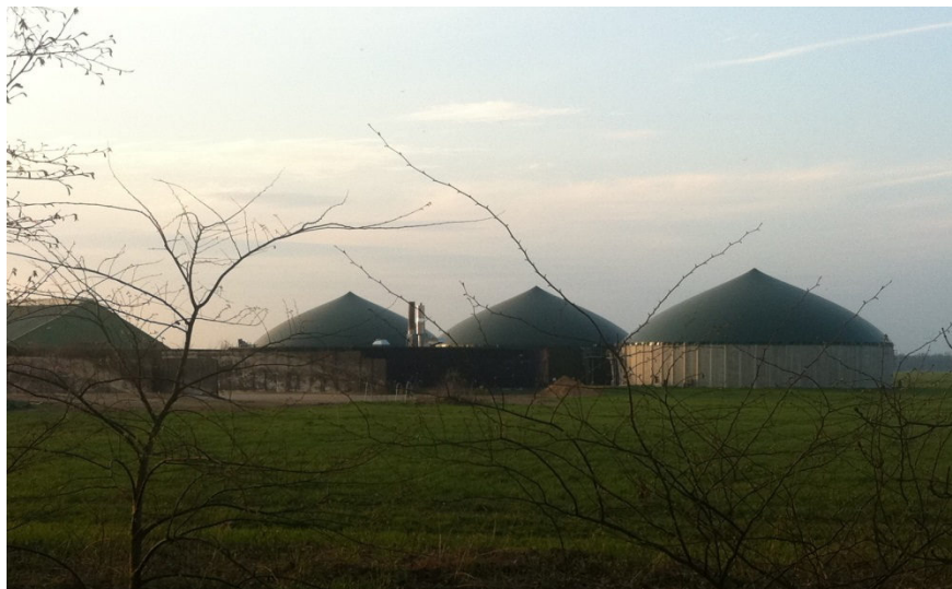
Biogasanlage in Voigtsbrügge
