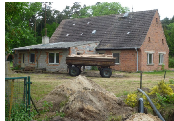
Siedlerhaus (Sanierung 2013 begonnen)
