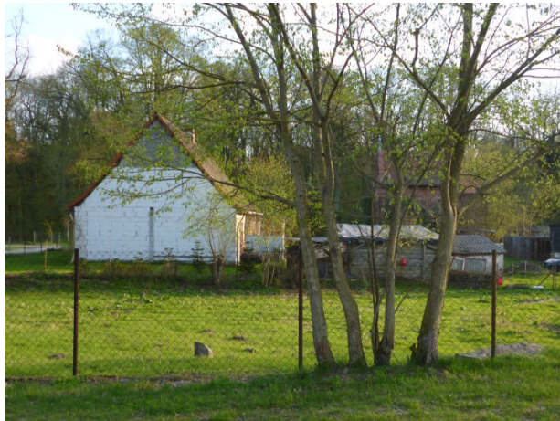
Siedlerhaus (auf Sanierung wartend)
