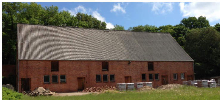
Hof und Halle des Bauunternehmens
