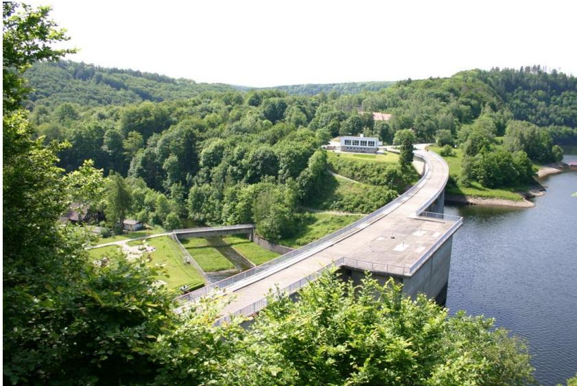
Gewichtsstaumauer aus Beton mit einem Bauwerksvolumen von 114.778 m<sup>3</sup>. Die Höhe über der Gründungssohle beträgt 43,5 m. Die Krone der Staumauer ist 230 m lang und 7 m breit. Der Stausee hat bei Vollstau eine Fläche von 78 ha, einen Beckeninhalte von 8,5 Mio. m<sup>3</sup> und eine maximale Tiefe von 33,0 m. Im Sommerhalbjahr ist das Stauziel auf 345,00 m ü NN festgelegt; das sind 6,90 m unterhalb des Vollstauziels (62 ha). Über
